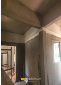
اعمال الدهانات داخل المبني
