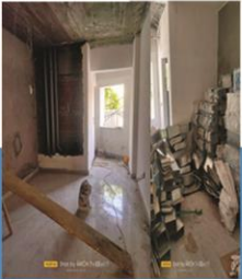
اعمال تاسيس التكييف بالسقف
