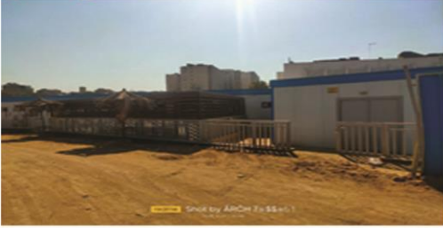
تركيب وبناء المنشآت المؤقتة
