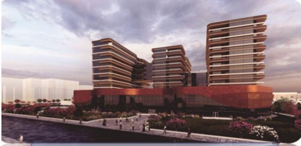
منظور خلفي لمبنى المستشفى الثلاثة أبراج الجديد
