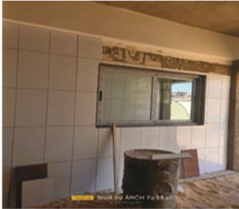
اعمال تركيب الشبايك الالومنيوم بالمبني
